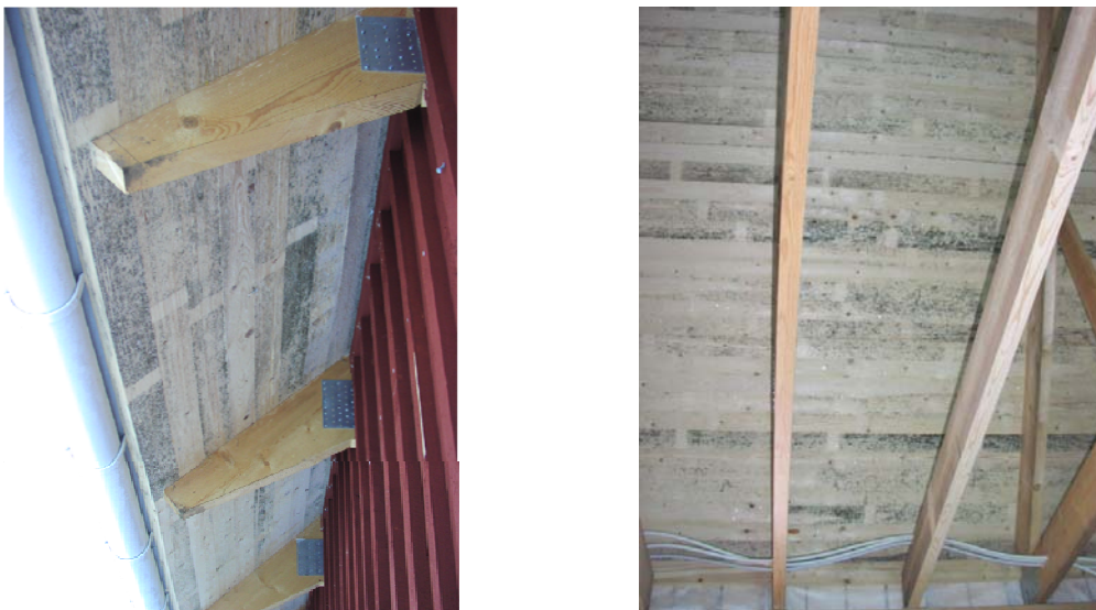
Figur 1.1 Synlig påväxt på råspont vid takfot och i carport. Påväxt har skett relativt snabbt efter det att taken har färdigställts.
